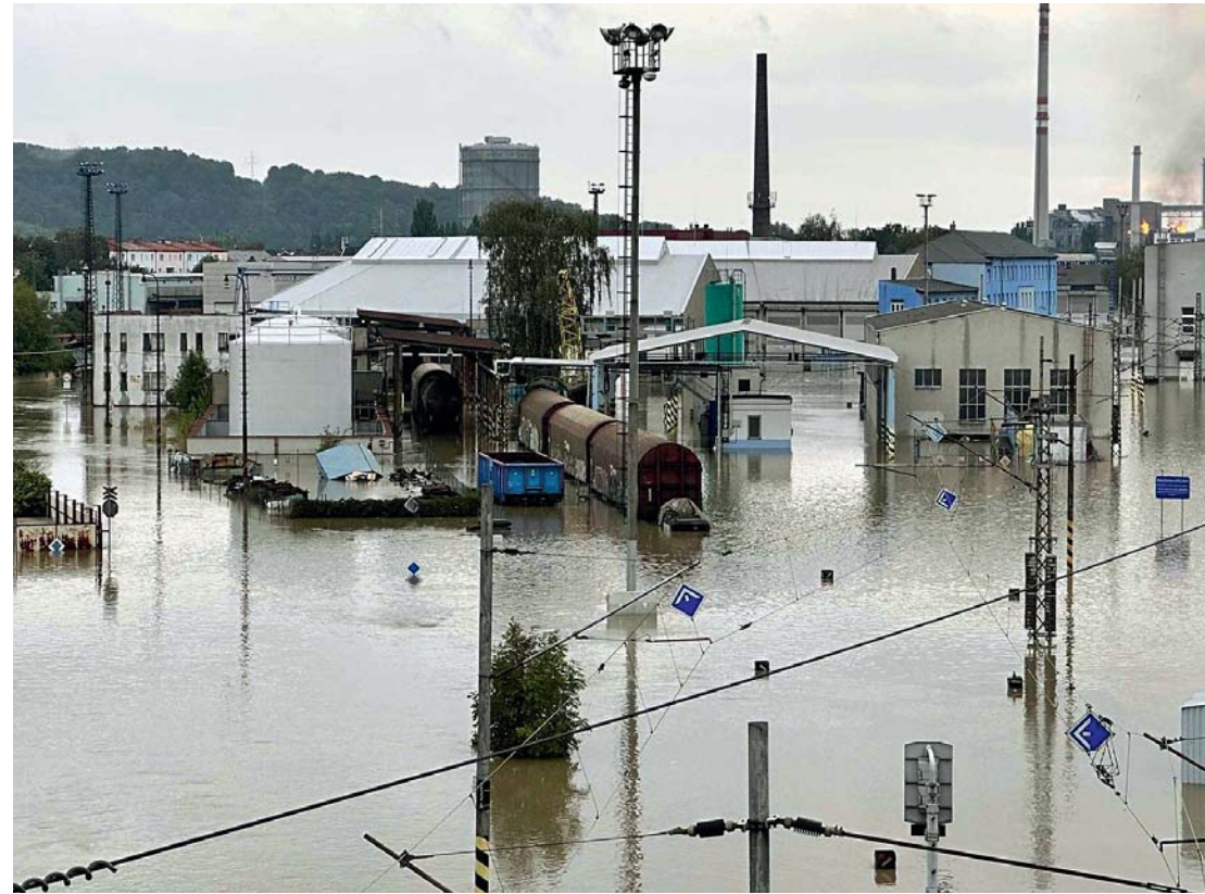
Zaplavené jižní zhlaví opravy hnacích vozidel v SOKV Ostrava
